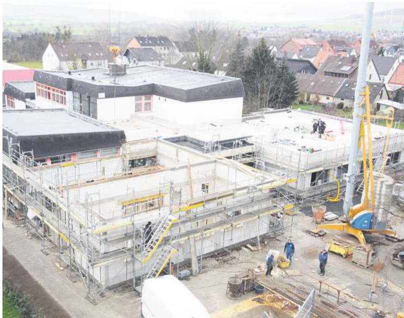
Für die Ganztagsbetreuung werden an der Bodenburger Grundschule ein Anbau für die Mensa und Gruppenräume errichtet.
