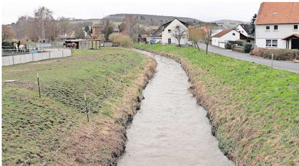
Klein Düngen: Links von der Lamme steht die Hochwassermauer schon, die rechte Seite soll folgen. FOTO: PEISKER
