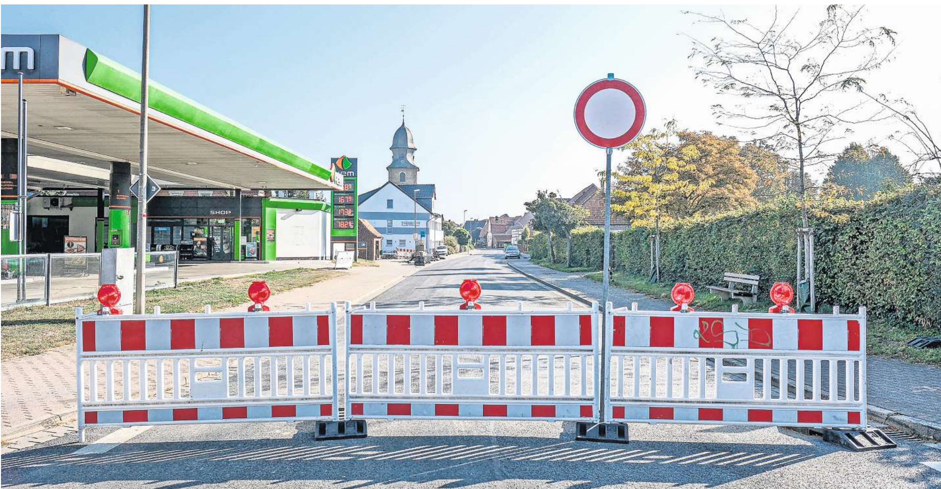
Noch ist die Ortsdurchfahrt in Groß Dungen gesperrt. Doch die Tage sind laut Landesbehörde gezählt.
